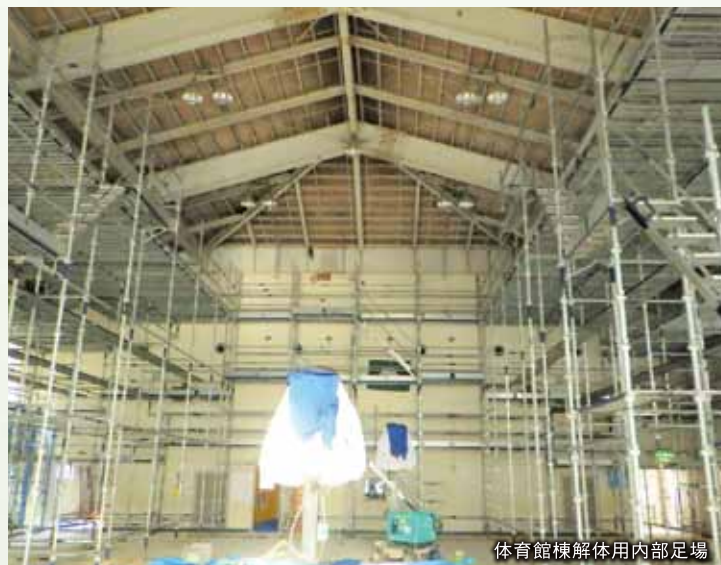
体育館棟アスベスト除去用足場
